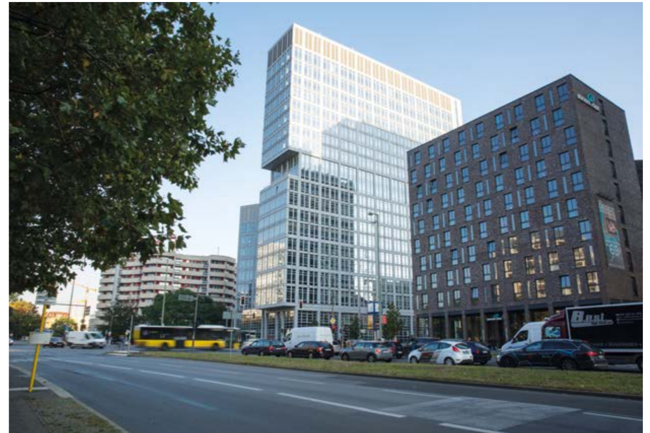
Markantes Gebäude: die VKA-Geschäftsstelle nahe der U-Bahn-Station Spittelmarkt in Berlin-Mitte
